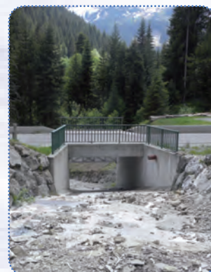
Aménagement du lit du torrent des Masses.
