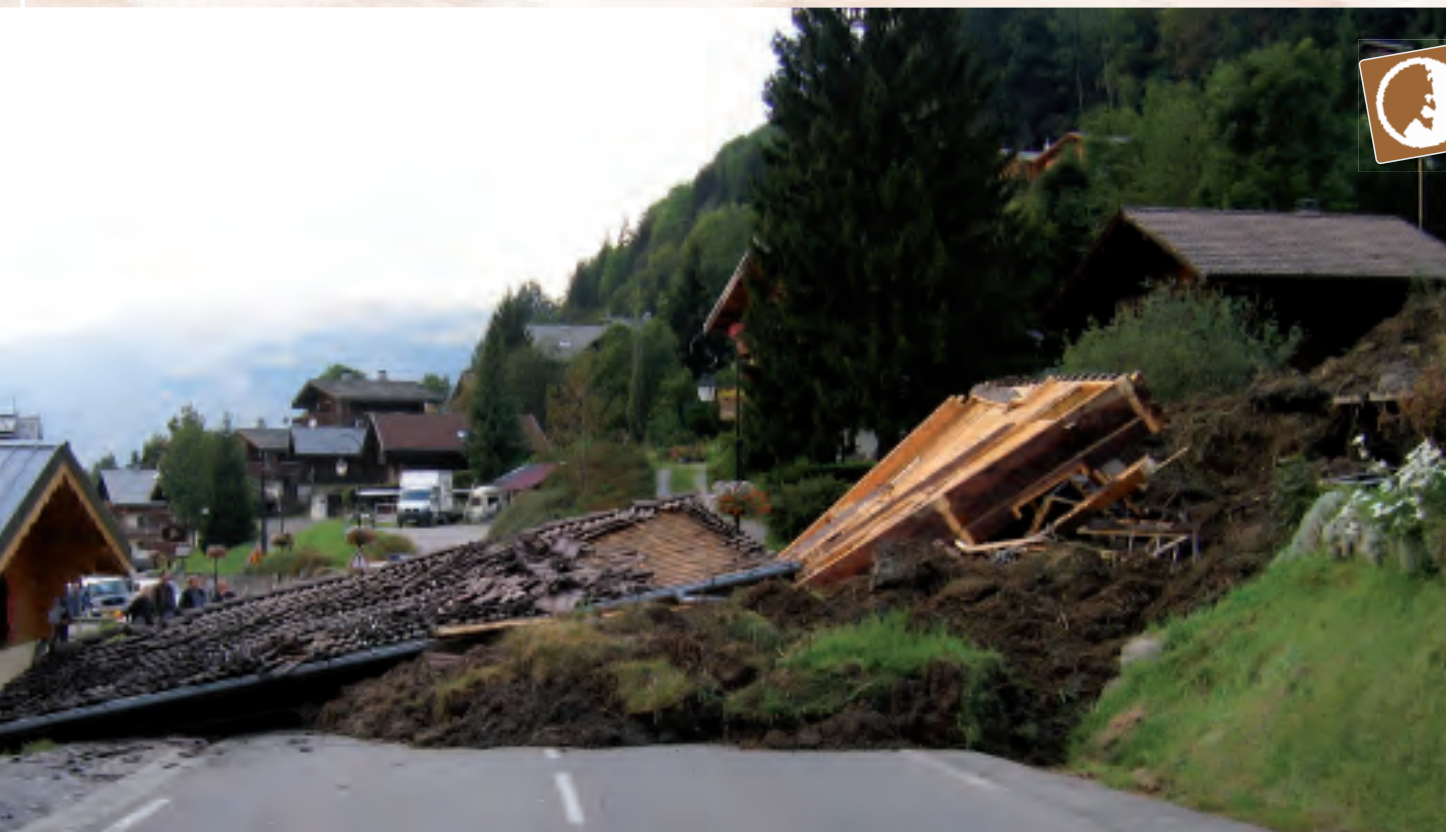
Glissement de terrain dans le hameau des « Sur les Grandes Mouilles » (19 septembre 2007).
