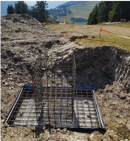
Les massifs en béton des ouvrages de lignes et des gares sont très densément ferrillés pour résister aux fortes contraintes apportées par la tension du câble.
